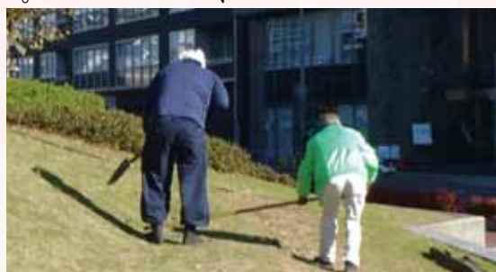
斜面を平らにならす作業
